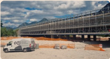
Rinforzo strutturale di un viadotto in Provincia di Udine
