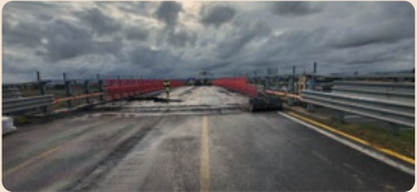
Lavori di risanamento di uno svincolo autostradale
