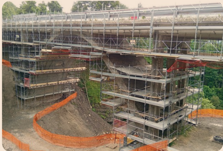
Messa in sicurezza di un ponte in provincia di Reggio Emilia
