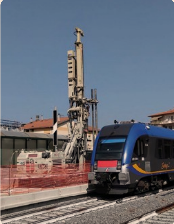
Realizzazione di paratia per costruzione sottopasso pedonale ferroviario
